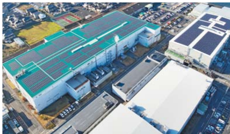
屋根に太陽光パネルを設置したC棟（右）、D棟＝丸亀市
