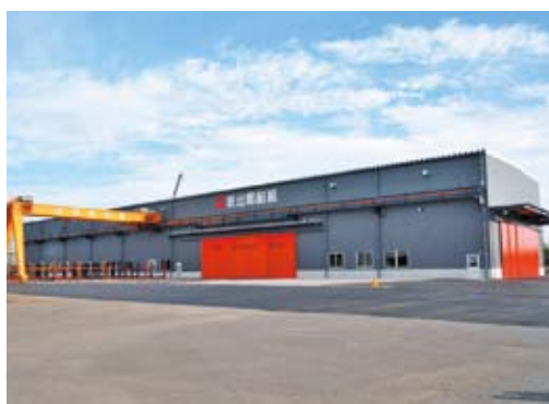
丸亀市蓬萊町に整備した新倉庫
